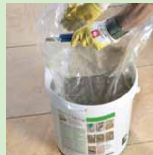
PE-Sack aufschneiden
