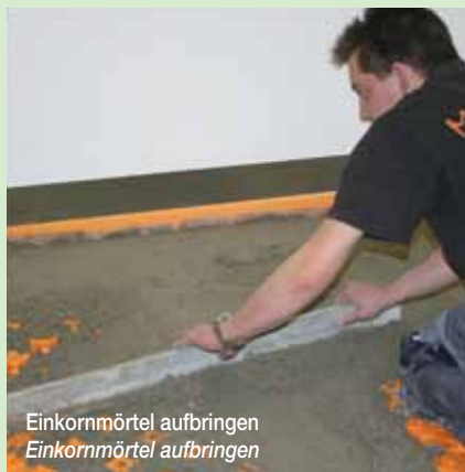
1 Bauwerksabdichtung / Cantilevered concrete slab. 2 Schlüter®-TROBA-PLUS BG 3 Schlüter®-BEKOTEC-DRAIN 4 Einkornmörtel / pervious mortar 5 koraTER® Elemente / koraTER® elements
