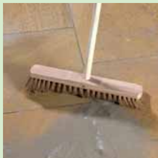
Mit feuchtem Besen letzte Mörtelreste abfegen
