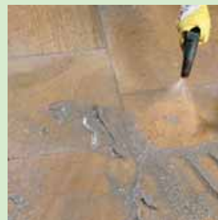
Mit weichem Wasserstrahl Oberfläche reinigen
