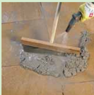
Mörtel mit Hartgummischieber u. Wassersprühstrahl einschlammern
