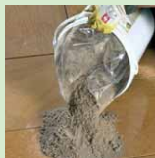
Mörtel portionsweise verteilen
